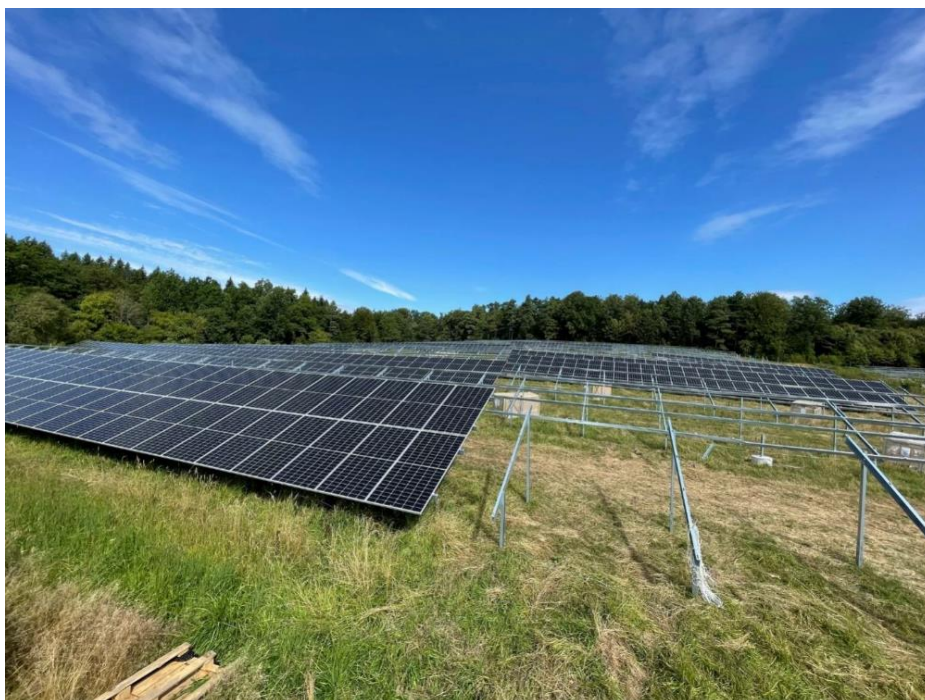
Figur 4. Exempelbild över solcellspaneler och montagesystem. ©Sunspark Nordic AB.
